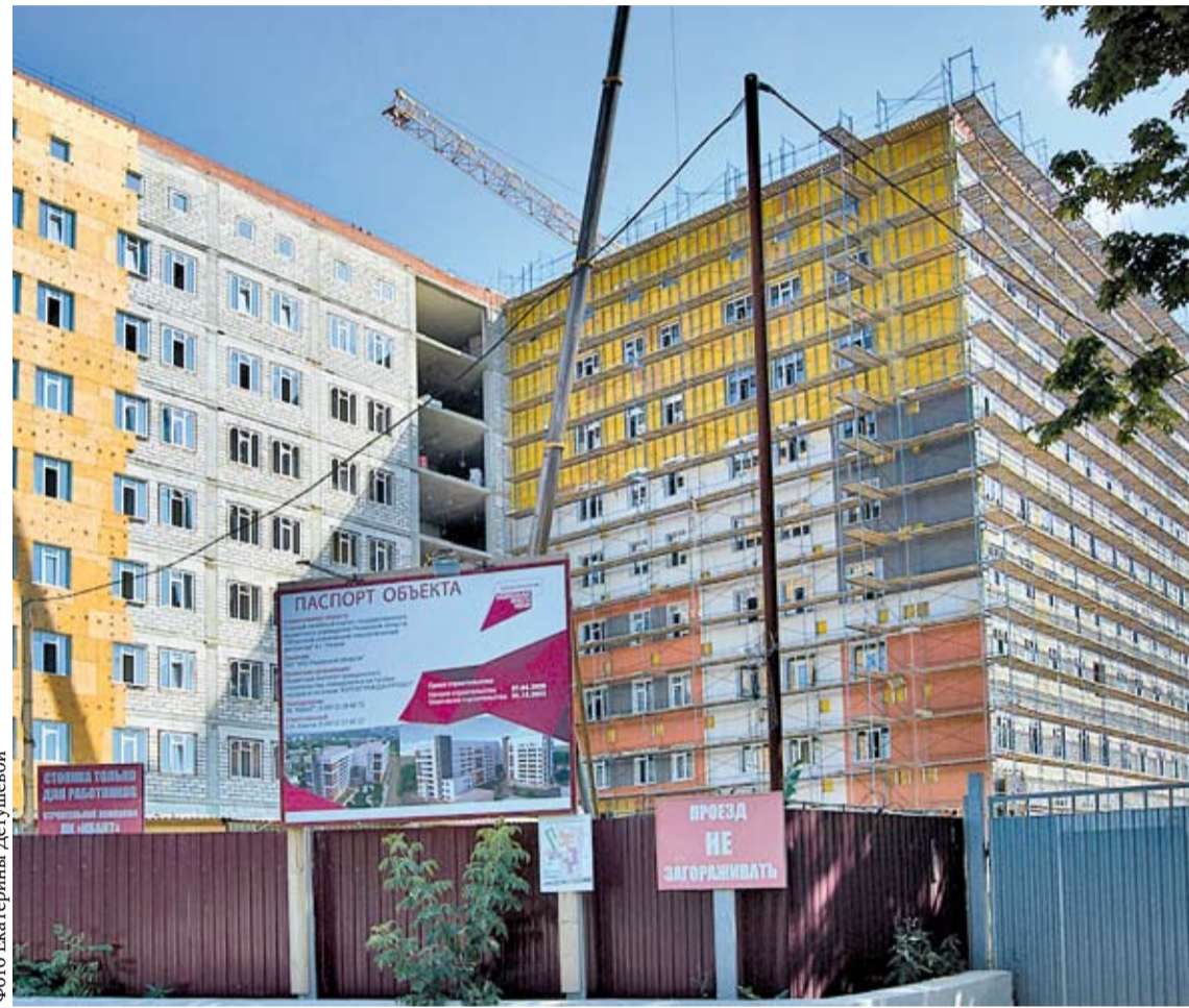
«Коробка» нового лечебного корпуса областного онкодиспансера на улице Спортивной возведена примерно за год. Следующий этап – внутренние работы и установка медицинского оборудования
